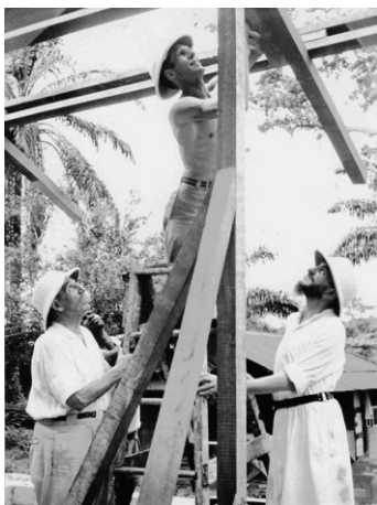
На стройке. Справа — Аббат Пьер
