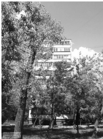
Новолесная ул. 18, к.1. Вид сбоку
