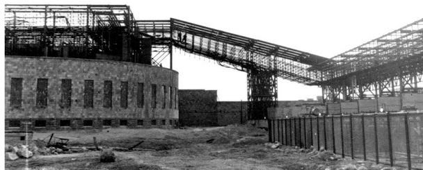
Ереванский электронный кольцевой ускоритель в период строительства. Слева здание ускорителя, справа — эстакада подачи электропитания
