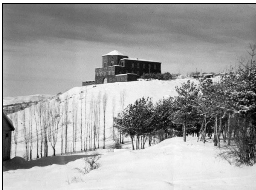
Высокогорная научная станция «Нор-Амберд» (2000 м над уровнем моря)
