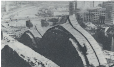
Гирей бьет чугунную решетку перед облицовочным виаз и стальной на завод б.Гужона для перелазки в мшинные части.
