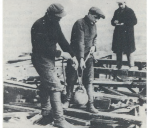
Гирей бьет чугунную решетку перед облицовочным виаз и стальной на завод б.Гужона для перелазки в мшинные части.
